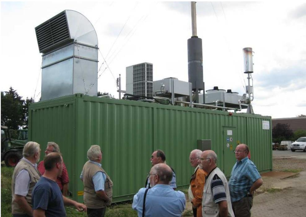
Die Herstellung des Biogases läuft natürlich auch bei einer Störung der BHKW weiter, allerdings ohne verbraucht werden zu können. Der Vorgang lässt sich nicht einfach abstellen und das Gas irgendwo zwischenlagern geht auch nicht, es muss also abgefackelt werden.
